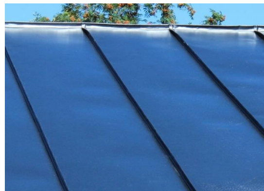
Bandtäckning Plåtslageriarbeten "Standing Seam profiles"
