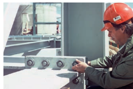
Göran Alpsten kontrollerar högt förspända M36-skruvar i det stabiliserande fackverkets ändplåtsförband. Då förbanden, det vill säga skruvar och muttrar, ej höll måttet för brott-hållfasthet fick de bytas ut.
