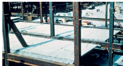
Kulturhuset där HSQ-balken och bjälklagselement "introducerades".
