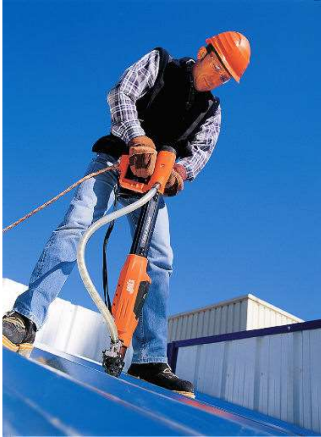
Stående skjutning av takplåt med bultpistol
