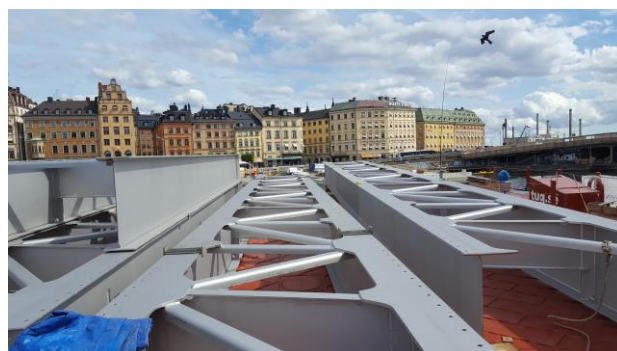
Brosektioner ligger här på en pråm vid Gamla Stan i väntan på montage.
