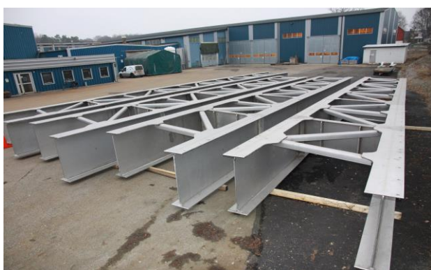
Färdiga brosektioner på Stål & Rörmontage gård i väntan på transport upp till Stockholm.
