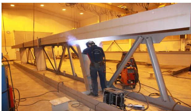
I Stål & Rörmontages verkstad svetsas delarna från Degerfors ihop till färdiga brosektioner.
