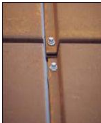
Infästning av fasadkassetter i rosttrögt stål. Skrudar av syrafast stål.
