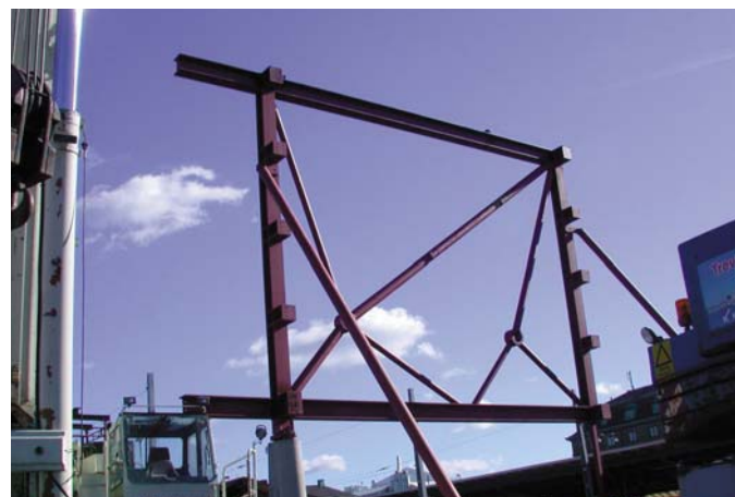
Det första huvudfackverkelementet är på plats.
