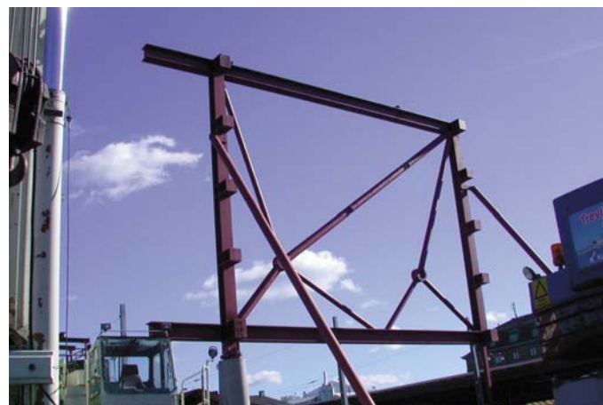
Det första huvudfackverkelementet är på plats.
